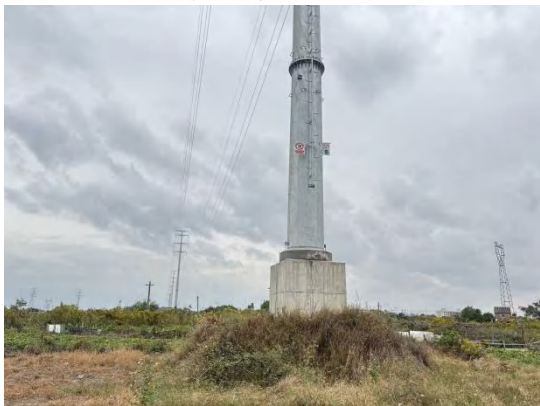
A20#塔基迹地现状
