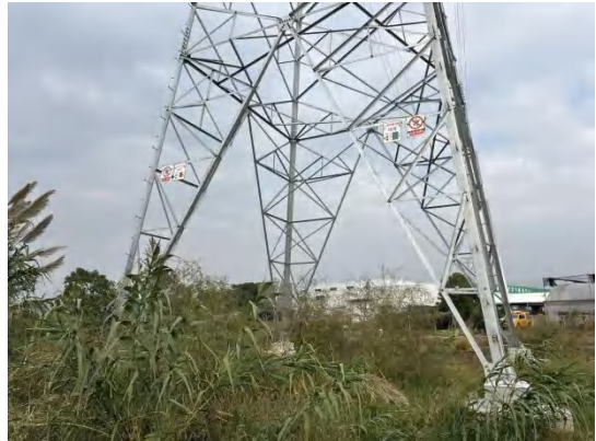
A3#塔基迹地现状
