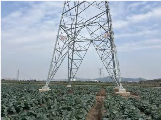
A1#塔基迹地现状
